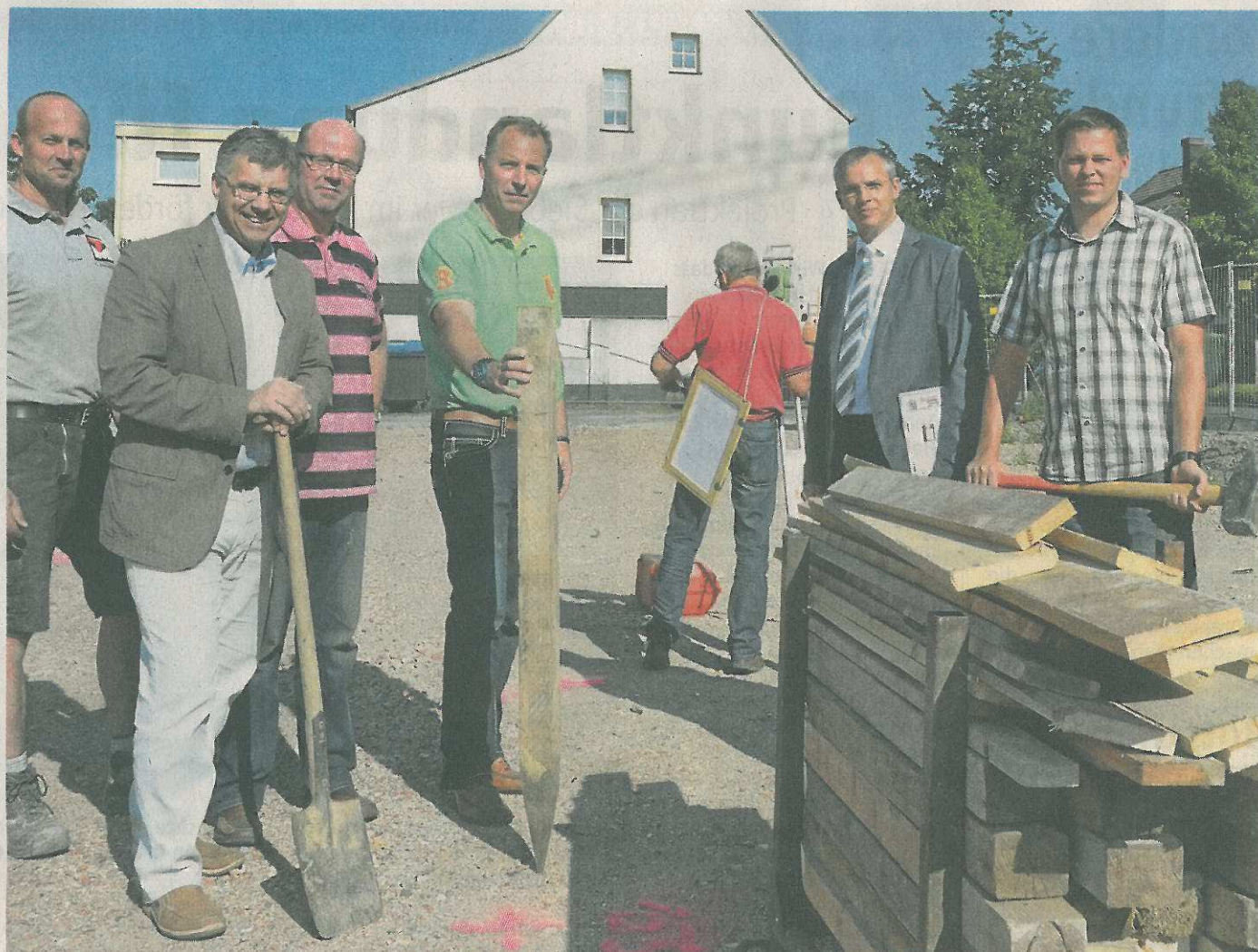
Am Mühlentor fiel gestern mit Vermessungen der Startschuss für ein neues Wohnobjekt. Guido Brinkschule (Bauunternehmen Mertmann), Architekt und Bauherr Jörg Jäger, Karl-Heinz Hahn (Elektro), Vermessungsingenieur Michael Strickling, Jörg Weißberg (VID Volksbanken Immobilien und Dienstleistungen) und Benedikt Grob (Firma Mertmann) trafen sich auf der Baustelle. RN-Foto Schrief
