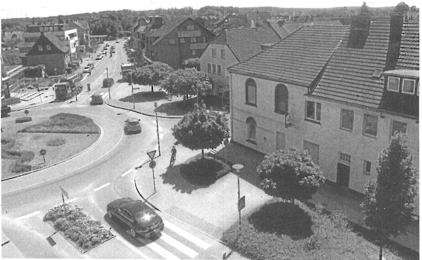
Am Kreisverkehr bewegt sich etwas. 2011 sollen an der Ecke Nordwall/Mühlenstraße die Bauarbeiten beginnen: Restaurant (früher Deutsches Haus), K&K-Markt und Wohnungen werden ersetzt durch ein neues Ärztezentrum mit Wohnungen. RN-Foto Schrief
